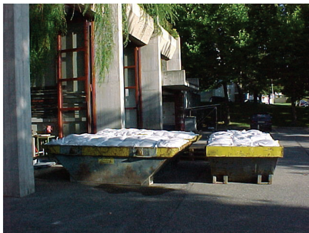
3 Bennes 5 m³ Environ 450 sacs par benne Poids environ 9 tonnes par benne
